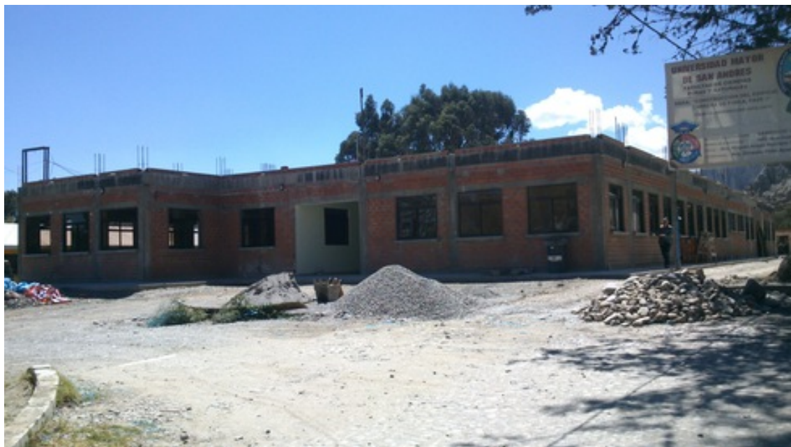
Figura 3: Primera planta concluida del nuevo edificio de cinco pisos de la Oficina Central de la Carrera de Física y el Instituto de Investigaciones Físicas en el mismo terreno en Cota Cota.
