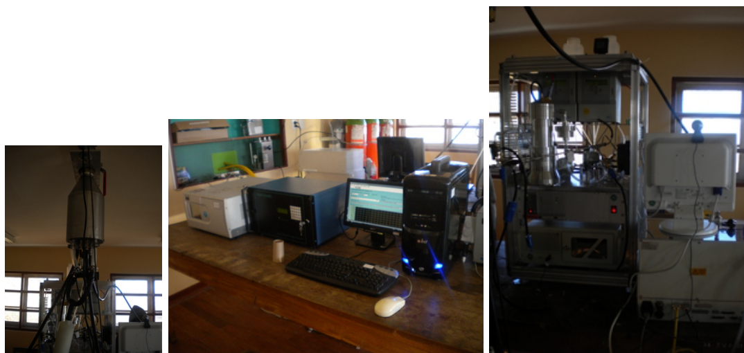
Figura 10: Instrumentos: Distribuidor de aire a todo los equipos, Medidores de CO, CO 2 y contador de Partículas
