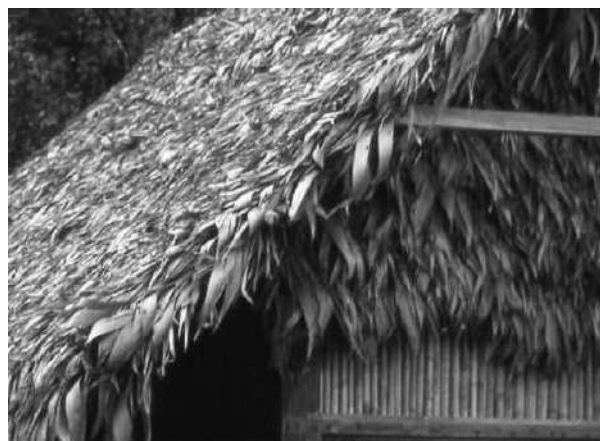
FIG. 2.— Techo elaborado con jatata (Trinidad – Beni) (Foto: M. Moraes).
